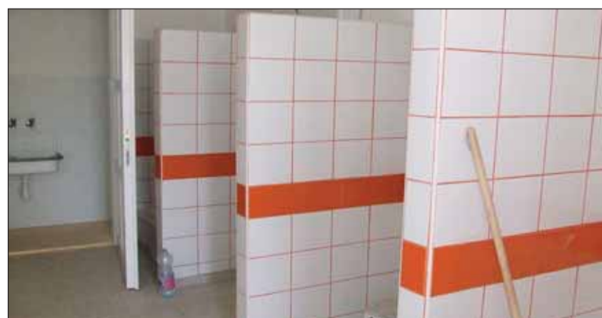
A saját erőből megvalósult átépítés a végéhez közeledik
