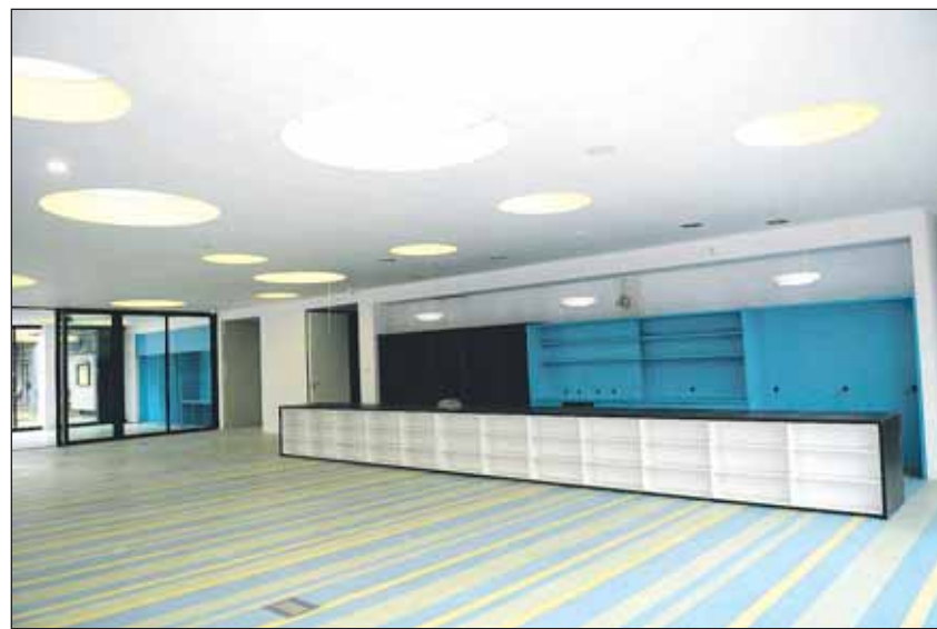
A műszaki ellenőrzést a bútorok elhelyezése követi
