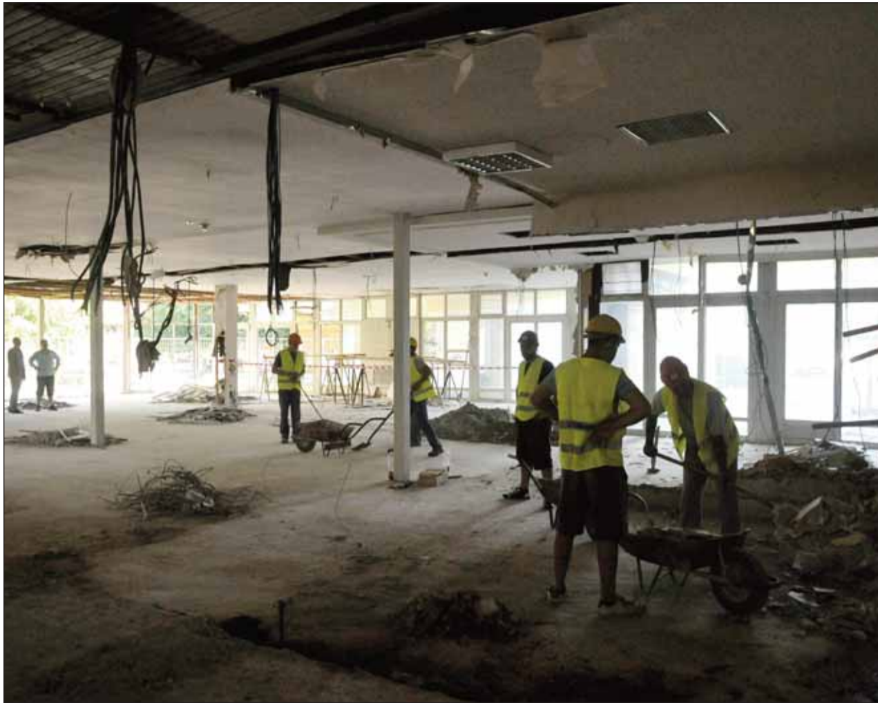
Az épület lecsupaszítását követően a kivitelezés látványos szakasza következik
