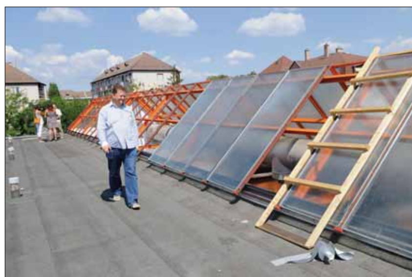
Rozgonyi Zoltán a Németh Imre Általános Iskola felújítását ellenőrzi
