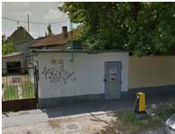
Öv utcai gáznyomásszabályzó épületben elhelyezve
