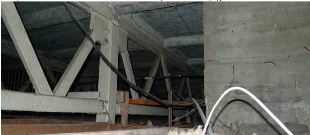
6. kép: acél rácsostartó és monolit vasbeton merevítő fal (fotó: Facskó Gergely)
