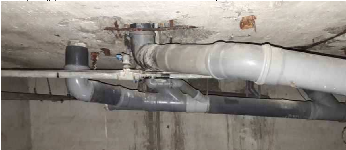
5. kép: pincei gépészet és a födém szabadon lévő rozsdás betonacéljai (fotó: Oltvai Tamás)
