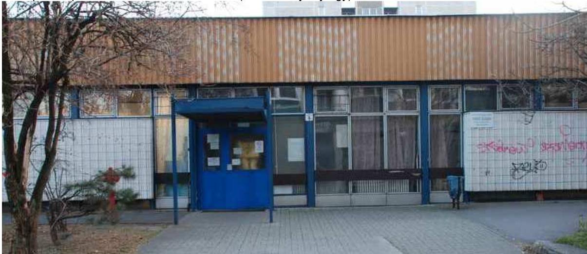
4. kép: 3/b épület oldalsó homlokzatrészlete (fotó: Selényi György)
