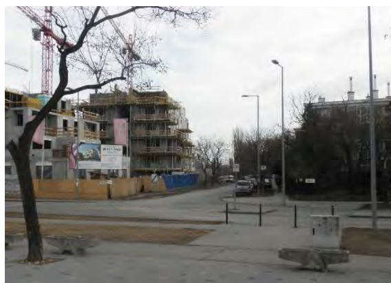
Régi kislakótelep és a Cordia építési területe
