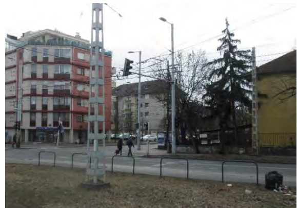
Vezér út felől az Egressy úti 5 emeletes beépítése
