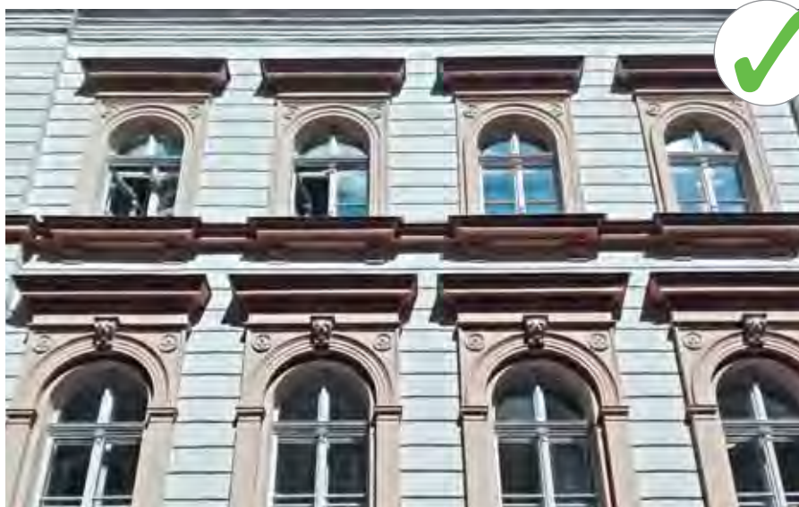
Szépén felújított homlokzat
