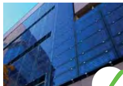
Épülethomlokzaton elhelyezett napelem megtervezett felülettel
