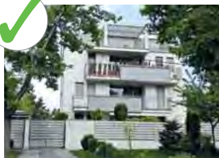
Új beépítés, jó épülettömeggel
