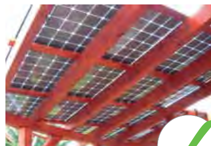
Gépkocsibeálló fedése napelemmel
