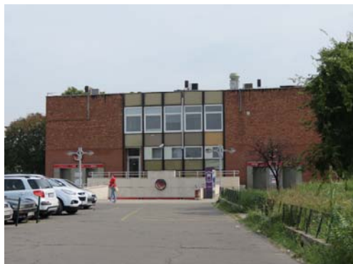
István út felőli Metró lejárata
