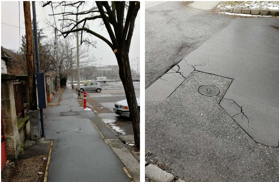
Föld feletti és föld alatti tűzcsap a Bosnyák utcában, illetve a Must utcánál
