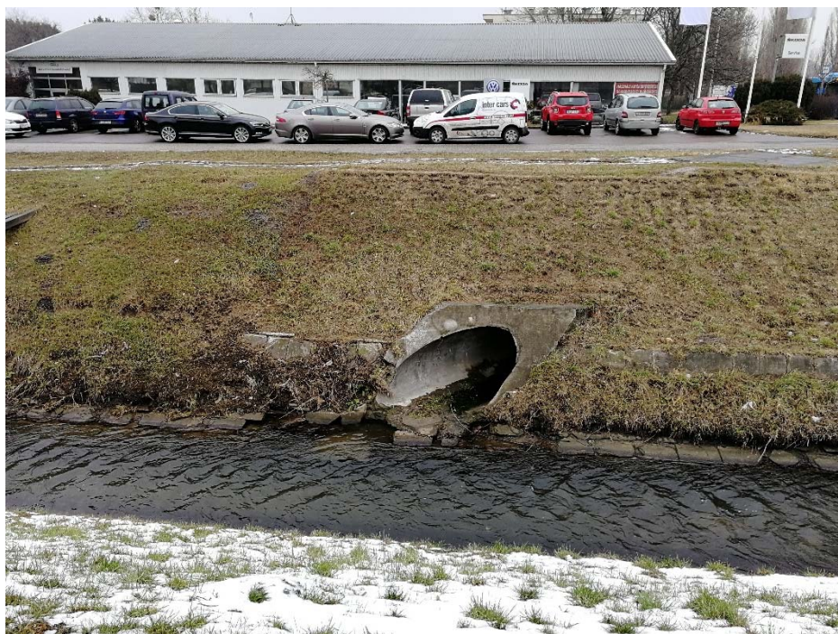
Nagyméretű csapadékcatorna bevezetés a Rákospatakba a Csömöri útnál
