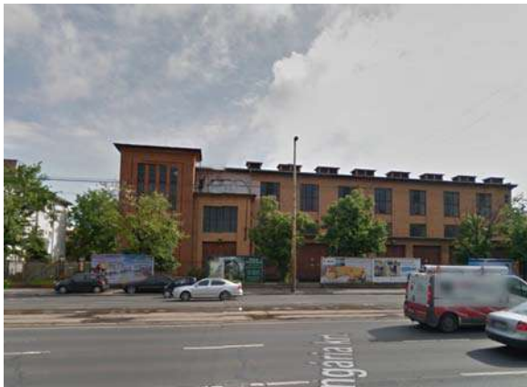
Városliget 120/10 kV-os állomás
