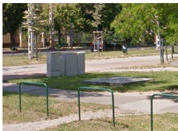
Egressy úti földbe süllyesztett nagyközép/kisnyomású gáznyomásszabályzó
