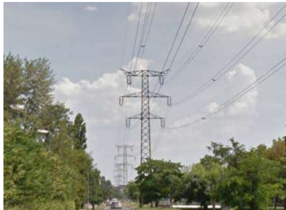
120 kV-os távvezeték a Rákospatak mentén
