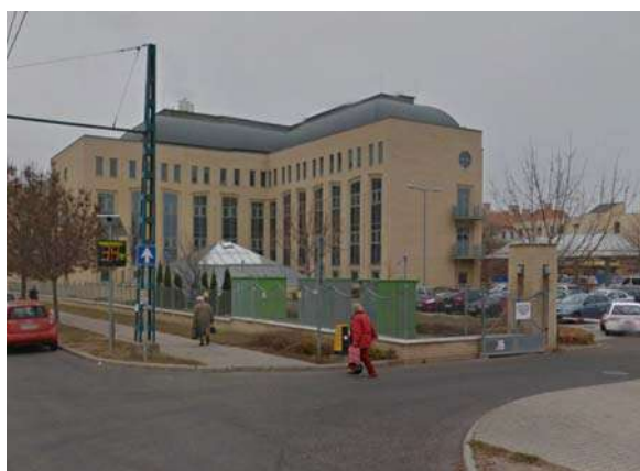
Róna utcai lemezházas nagyközép/közép- és nagyközép/kisnyomású gáznyomásszabályzó
