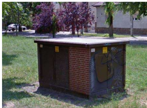
Építettházas 0441 sz. 10/0,4 kV-os transzformátor (Örs vezér útja)
