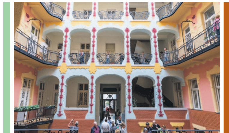
A Szenes Mór építtette egyik legszebb szecessziós bérpalota belső homlokzatát eredeti formájában újjáélták fel a ház lakói
