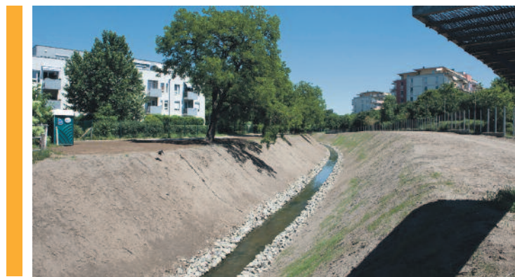
Betonmeder helyett Reno matracot raknak le
