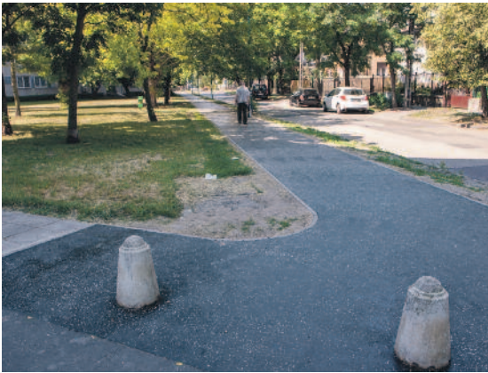
Ahol lehet, kerülük az aszfaltot a burkolatrehabilitáció során
