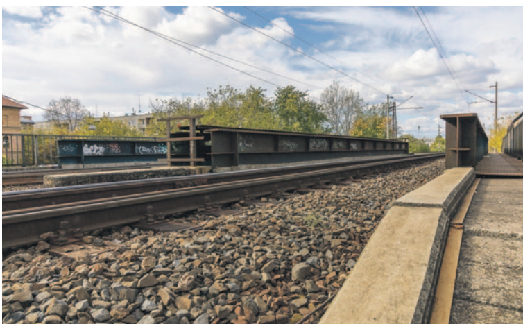
A felső pályás vasúti híd
