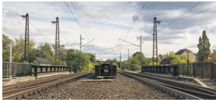
A két külön elemből épített vasúti híd
