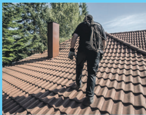
A kémények környezetét, a tetőjárdák állapotát és a tetőszerkezetet is vizsgálják
