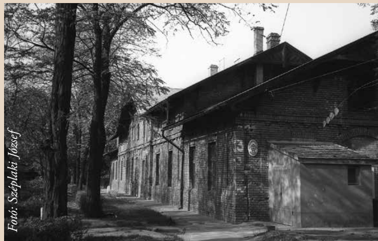
A hosszú irodaépület a Postatelep Stefánia úti részén helyezkedett el
