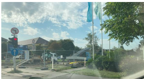
Építkezés a Csömöri út felől / saját fotó
