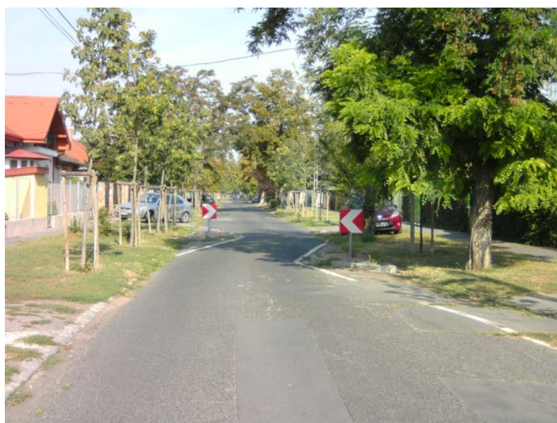
65. ábra Forgalmi sáv szűkítése terelőszigetekkel a Bátorkeszi utcában a Boros Mátyás utcai csomópont előtt
