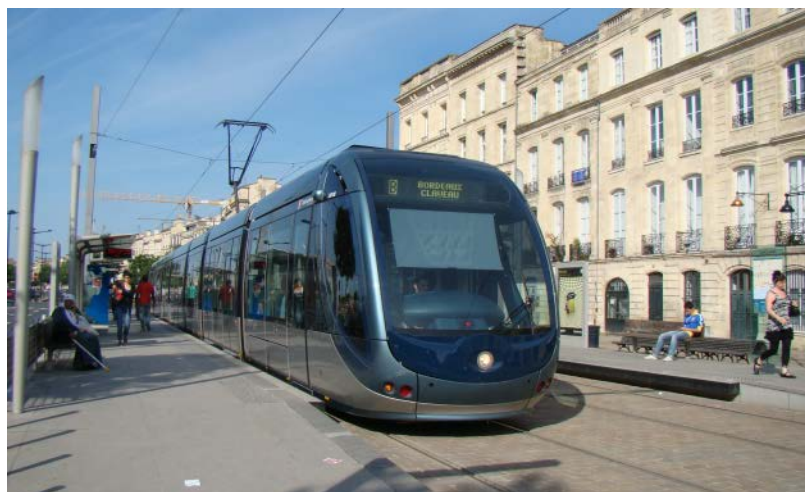
20. ábra: ...és sűrűbb beépítésű környezetben is
