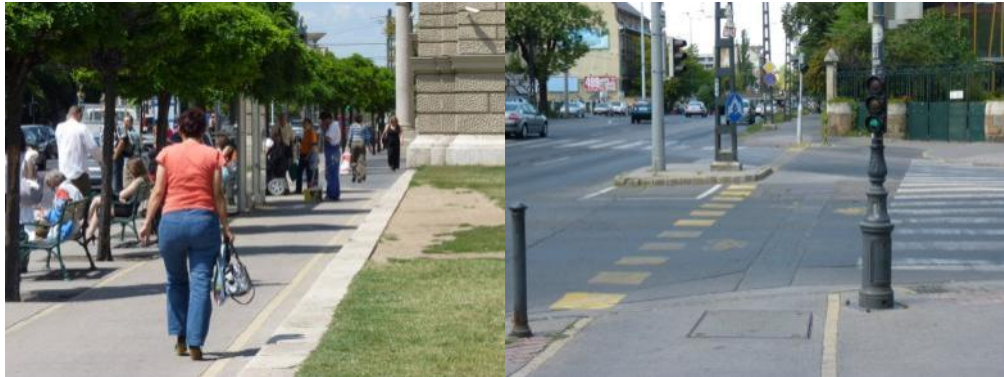
43. ábra: A járdán kijelölt, nem irányhelyes, néhol elhanyagolt Dózsa György úti kerékpárút
